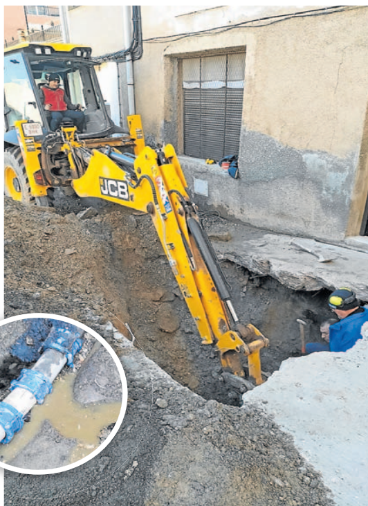
Reparación en la canalización de agua de boca de la cuesta de San Gil el 31 de diciembre. AYTO. CERVERA
