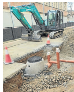
Trabajos en la red en la calle Andrés Martínez. AYTO. CERVERA
